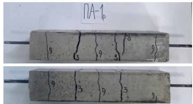
Рис. 5. Схема (розгортка) утворення і розвитку тріщин в призмі ПА-1р за розтягу арматури Fig. 5. The scheme (scanning) of cracks formation and development in the prism PA-1t during tensile reinforcement
